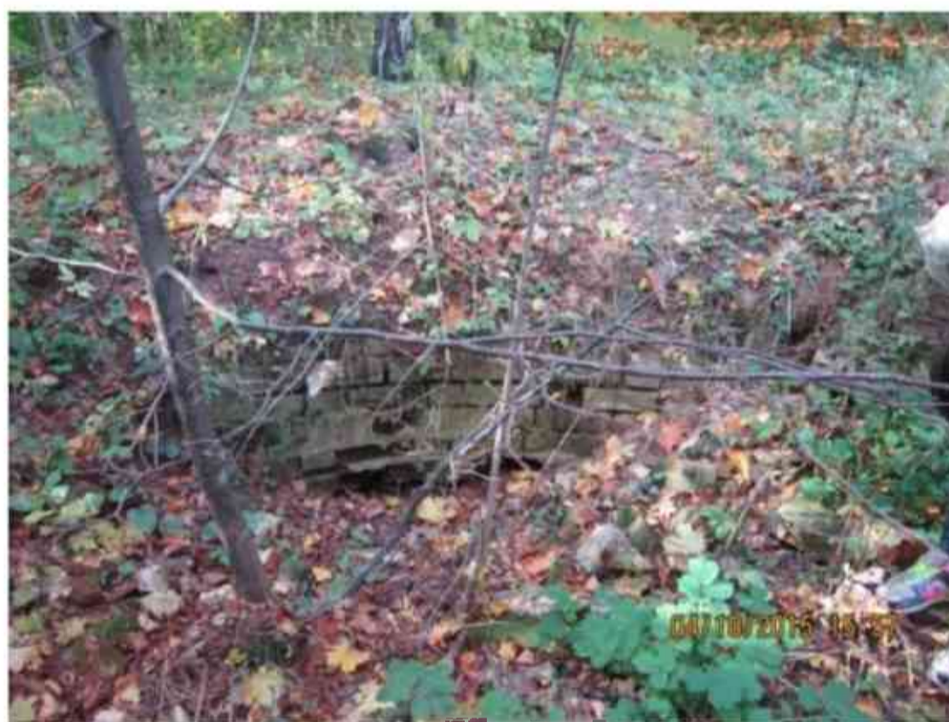
Фундамент Барского дома в д. Митино
